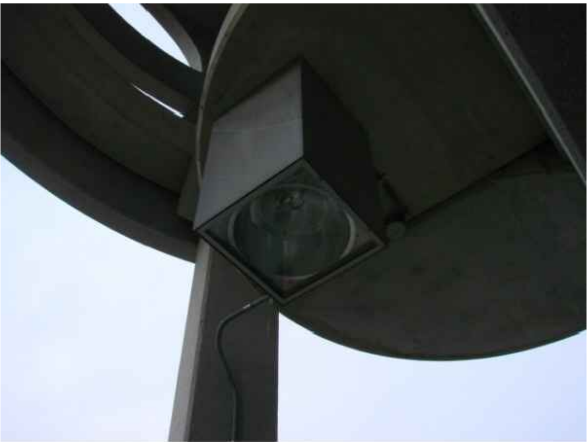
22 LIGHTING FIXTURE LAMP OUT E-503 SCALE: N.T.S.
