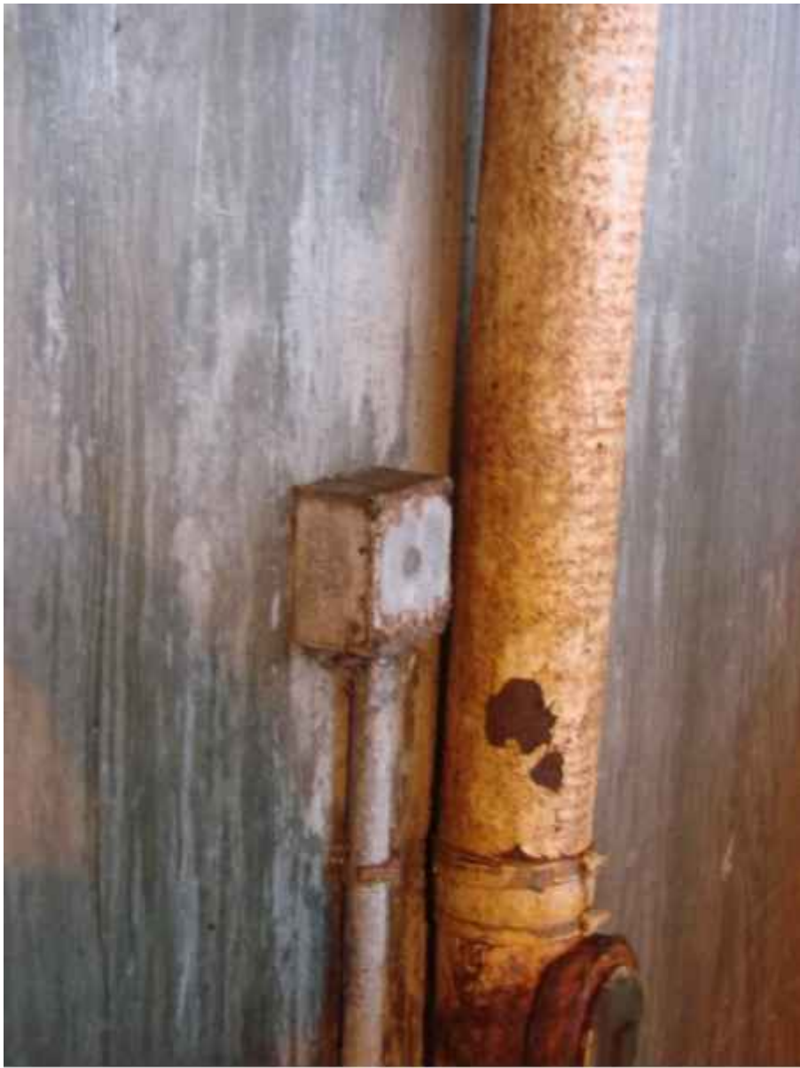
18 JBOX CORRODED E-503 SCALE: N.T.S.
