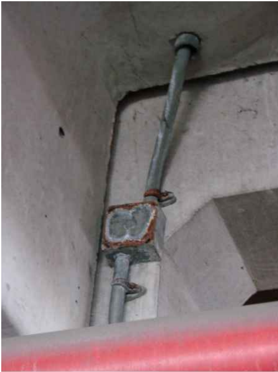
17 JBOX COVER CORRODED E-503 SCALE: N.T.S.
